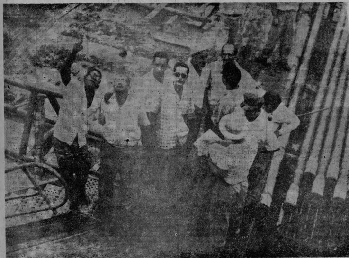
Recoge la gráfica de Araya el momento en que un grupo de dibujados visita los trabajos de perforación del Pozo de San Andrés, de la Compañía Petrolera Nacional, en la semana pasada. Están observando cómo se eleva, en la alta torre que se levantó allí, un tubo más para ser luego metido entre la tierra en busca de la profundidad que se espera alcance la perforación para encontrar el ansiado petróleo. Siguen adelante los trabajos y con gran optimismo de parte de los directores de la obra.
